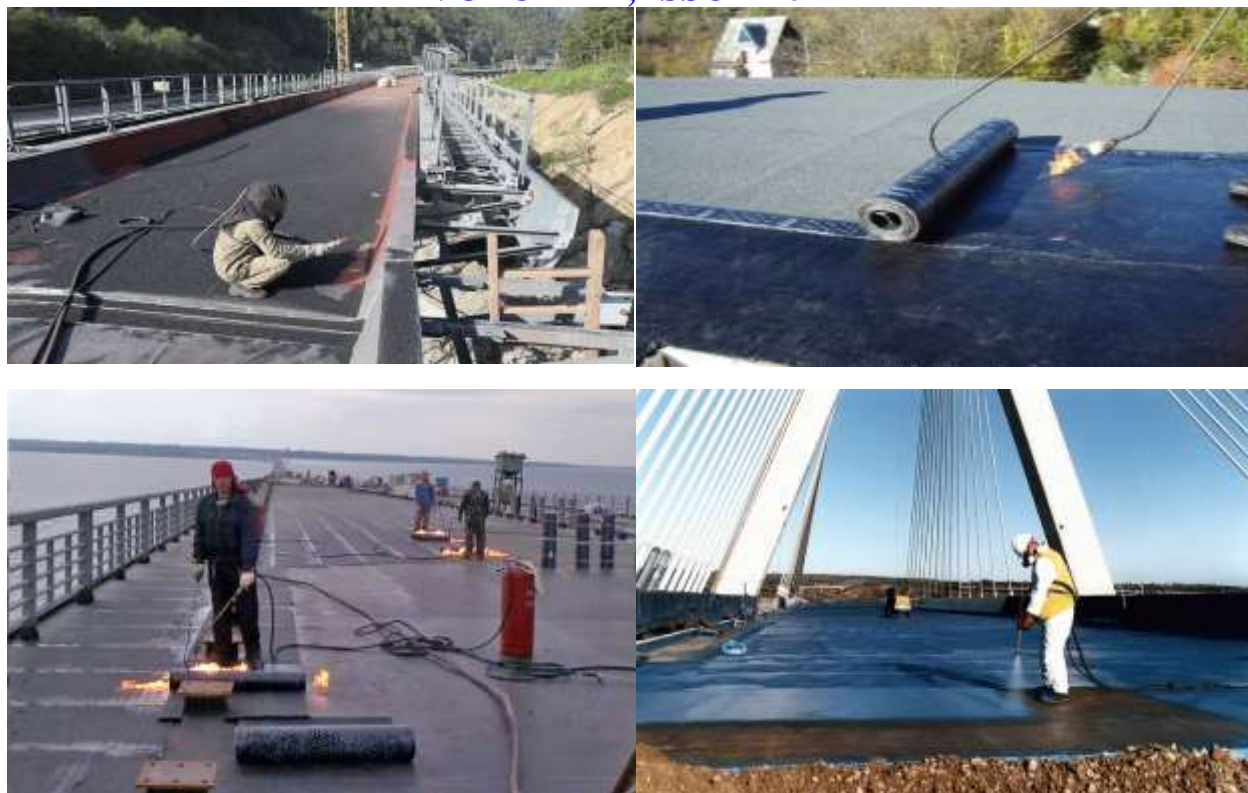
3-rasm. Ko‘prik poltnosida gidroizolyatsiyani yotqizilish jarayonlari
