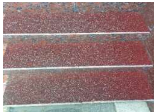
1-rasm: Avtomobil shinalarining maydalangan bo'laklari rezina plitka to'shalgan zina yuzasi.
