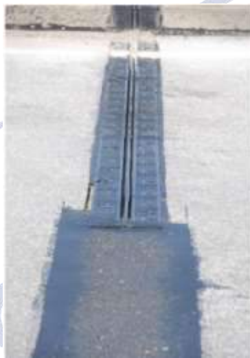
Рис.5. Временный ремонт отломанных участков армированного эластомерного шва
