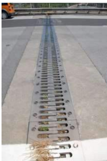
Рис.7. Резбовый/зубчатый компенсатор
