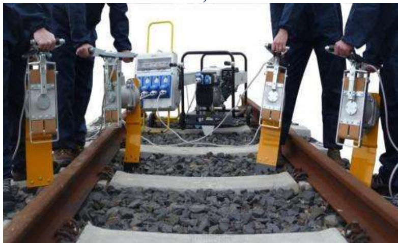
1-rasm. Elektrosfpalaurgich (ЭШП) dan foydalanish.
