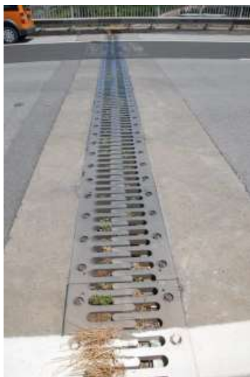
Рис.7. Резбовый/зубчатый компенсатор
